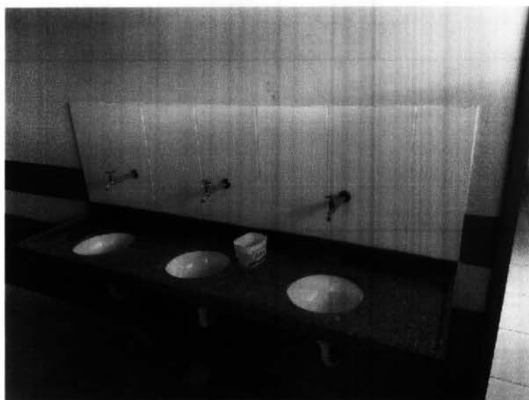
Imagem 12 – Reparo nos pontos hidraulicos e sanitarios dos banheiros da escola.
