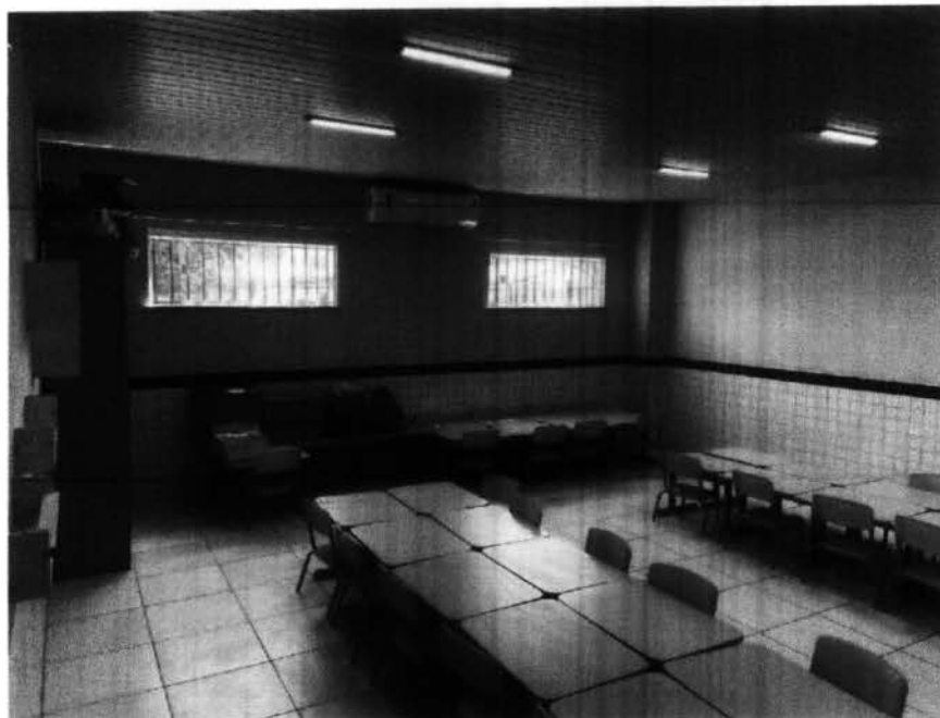
Imagem 9 – Pintura interna assentamento de revestimento cerâmico 10x10 nas paredes internas das salas e substituição de piso cerâmicos 60X60 danificados.
