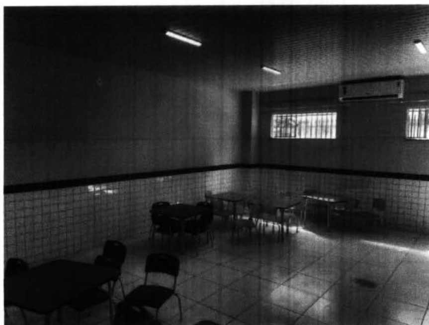
Imagem 8 – Pintura interna assentamento de revestimento cerâmico 10x10 nas paredes internas das salas e substituição de piso cerâmicos 60X60 danificados.
