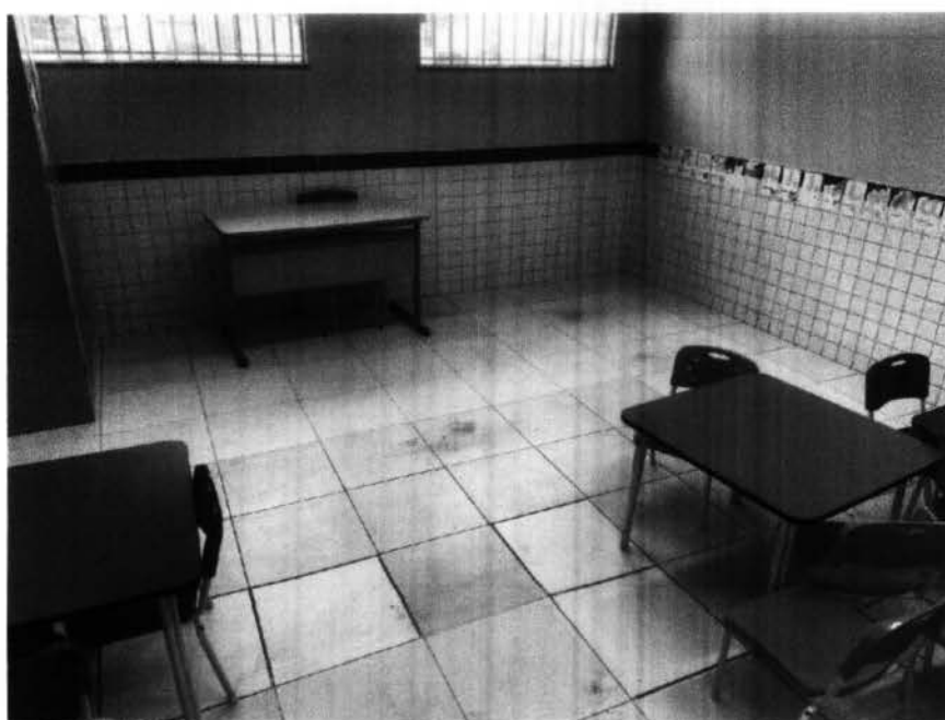
Imagem 10 – Pintura interna assentamento de revestimento cerâmico 10x10 nas paredes internas das salas e substituição de piso cerâmicos 60X60 danificados.
