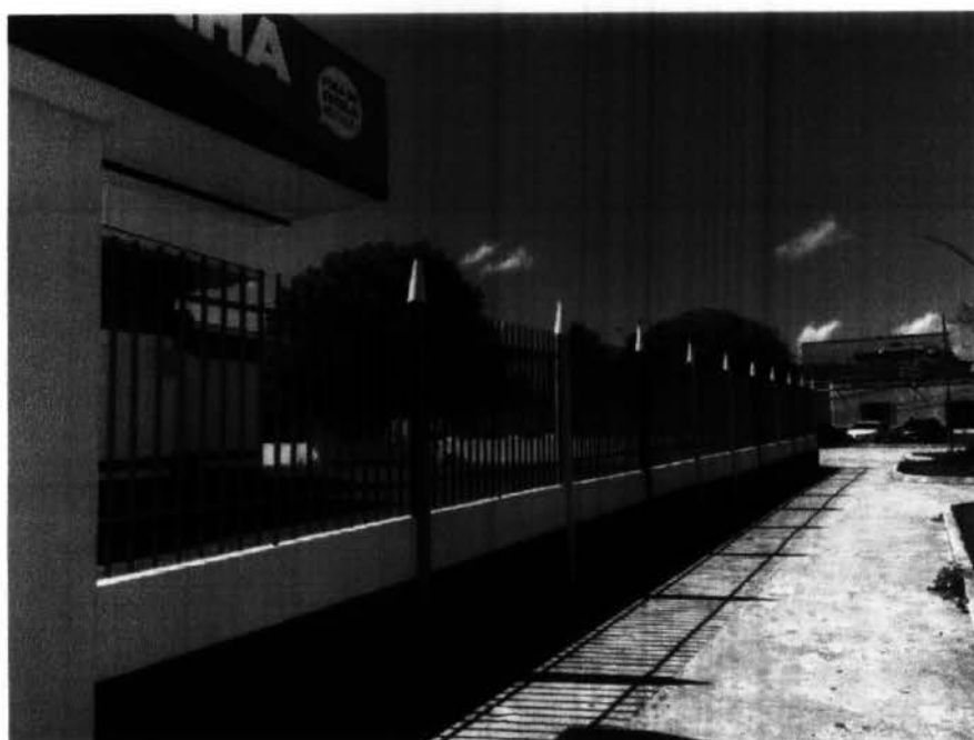
Imagem 2 – Pintura da fachada da escola.
