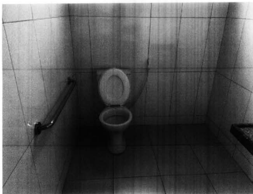
Imagem 11 – Reparo nos pontos hidraulicos e sanitarios dos banheiros da escola.
