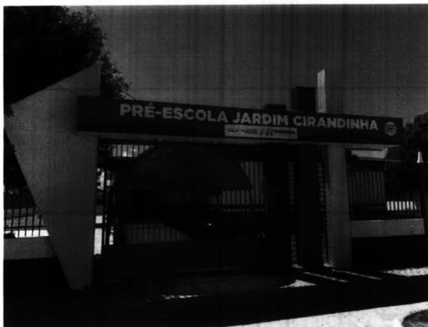
Imagem 1 – Pintura da fachada da escola.
